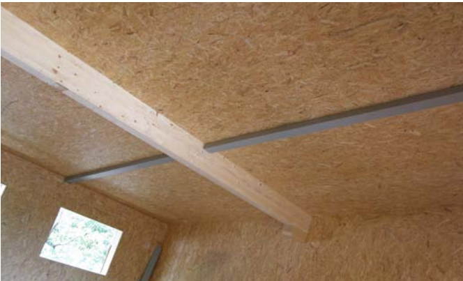
Kabelkanal verleeën
